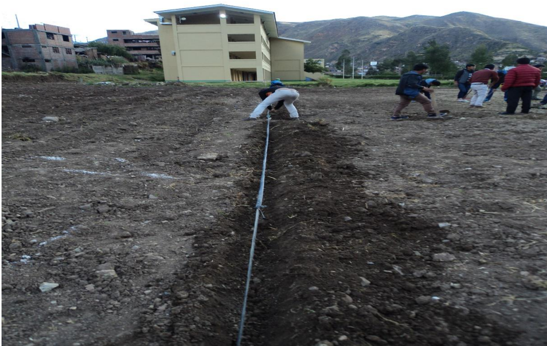
Instalación de sistema de riego
